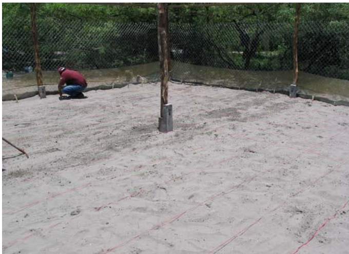
Fig. 8. Corral en proceso de construcción y colocación de cordel
