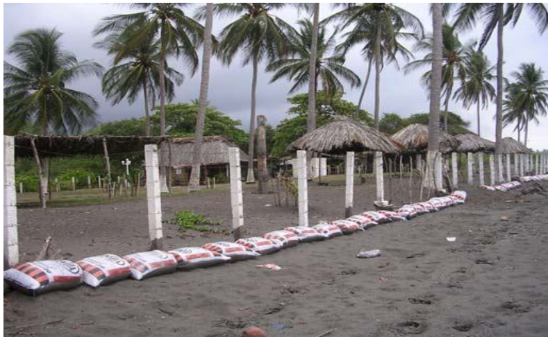
Fig. 11 Colocación de sacos con arena para proteger el corral de la erosión por olas
